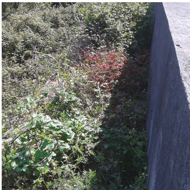
5. Vista posterior muro
